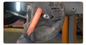
Bringen Sie die mit der Radnabenlagerung zusammmengebaute Bremsscheibe an.
